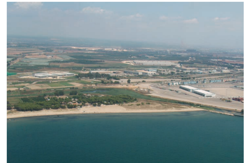
La foce armata del fiume Tara e gli accumuli di sedimenti indotti dal molo del nuovo porto
