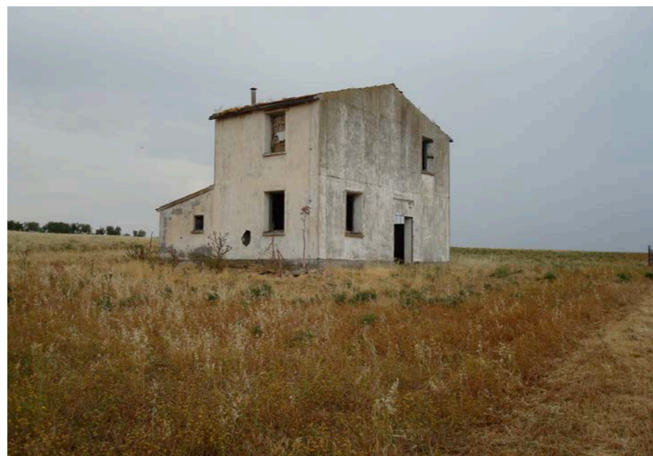
Edifici della Riforma ormai abbandonati
