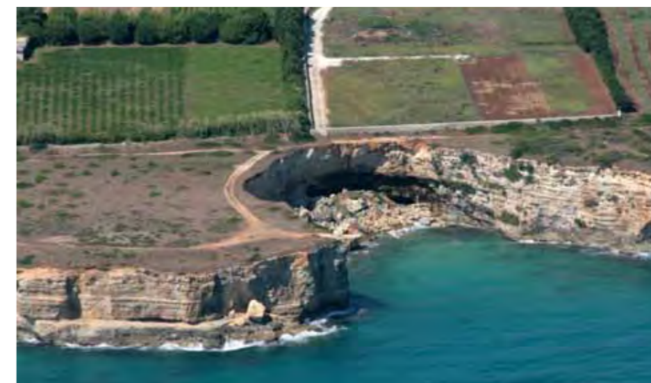
Otranto, falesia soggetta a fenomeni di crolli e cedimenti
